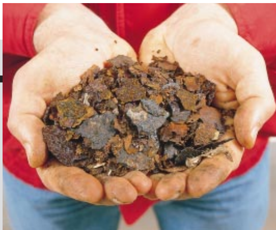
Zwei Hände voll Rost nach nur drei Jahren: Unser Test zeigt, dass eine aufwendige Rostschutzkur leider auch so enden kann
